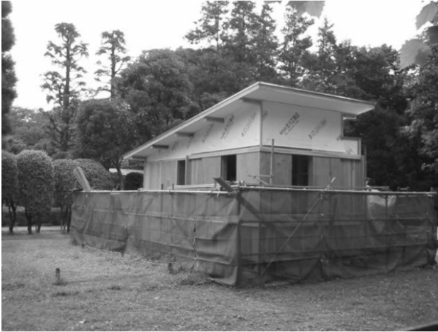
写真・5 竣工間近なヒアシンスハウス（2004年7月）
